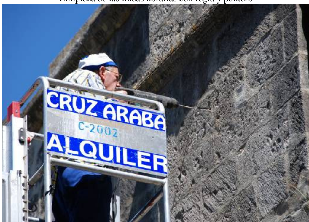
Taladrado del orificio en la junta tapada con cemento.
